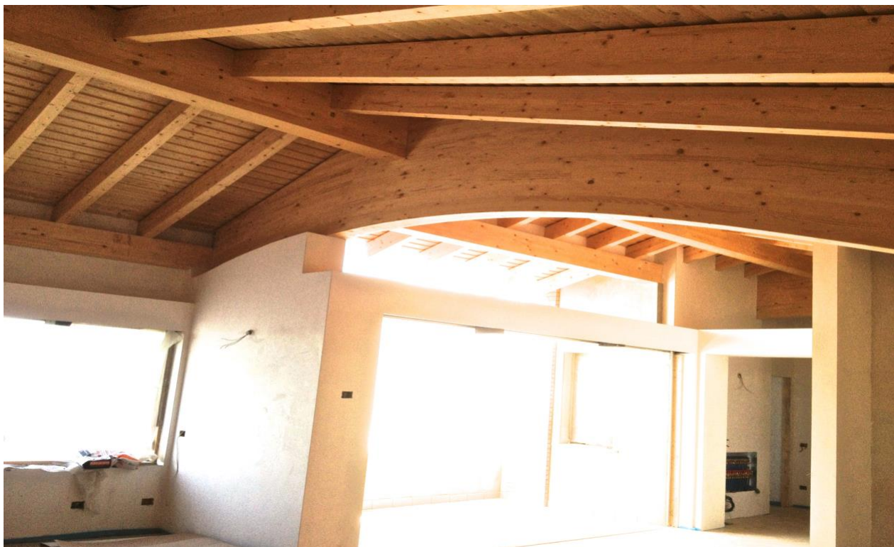
Figura 1 costruzione tetto in legno
